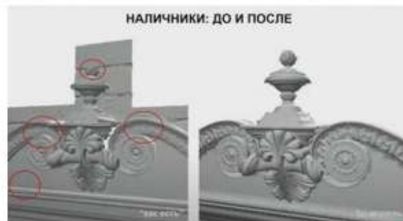
Рис. 4. Применение технологии 3D-моделирования цифрового макета оконных наличников
